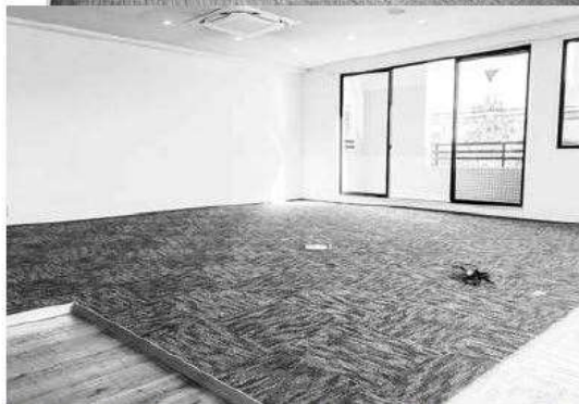
▲置敷きのOAフロアとタイルカーペットの組み合わせ
